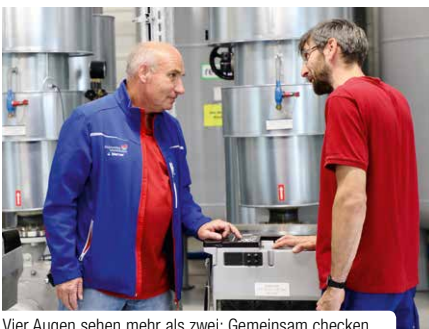
Vier Augen sehen mehr als zwei: Gemeinsam checken Jens Werner (l.) und Robin Schulz die Netzpumpenanlage
