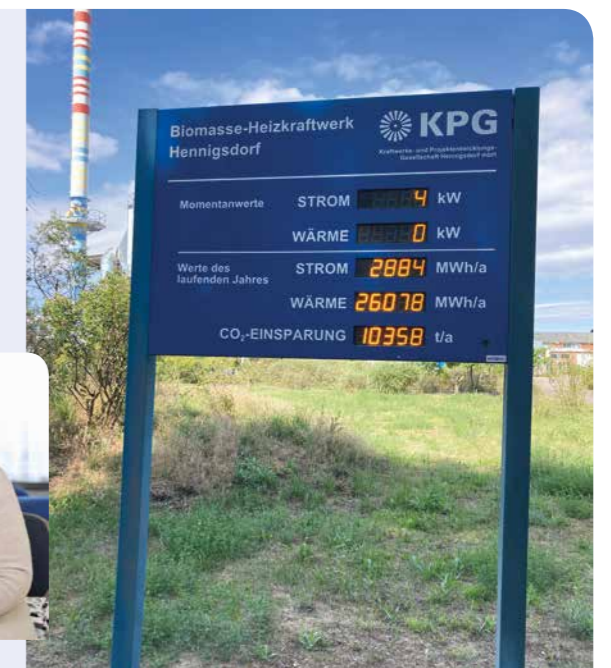
Anzeigetafel im Juli 2023. Zu diesem Zeitpunkt lief eine Revision des Kraftwerkes
