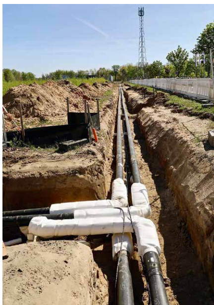
Über 300 m Fernwärmerohr, verlegt im öffentlichen Straßenland
