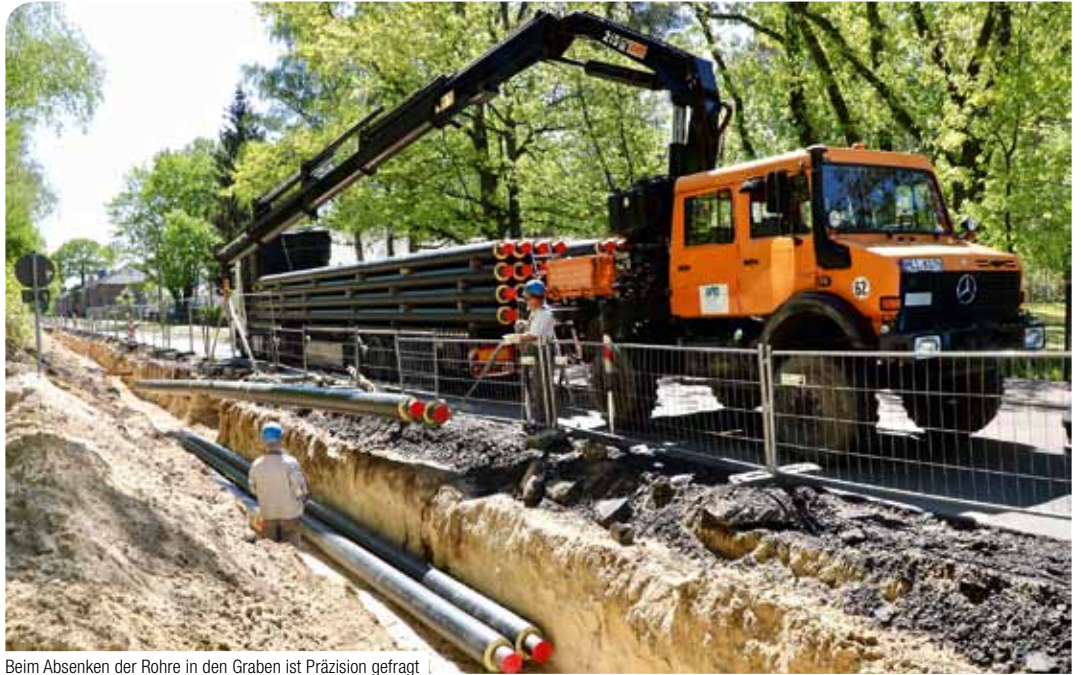
Beim Absenken der Rohre in den Graben ist Präzision gefragt |
