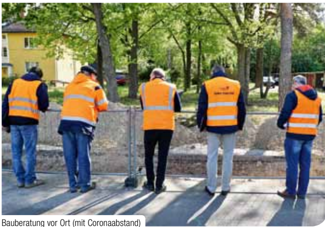
Bauberatung vor Ort (mit Coronaabstand)
