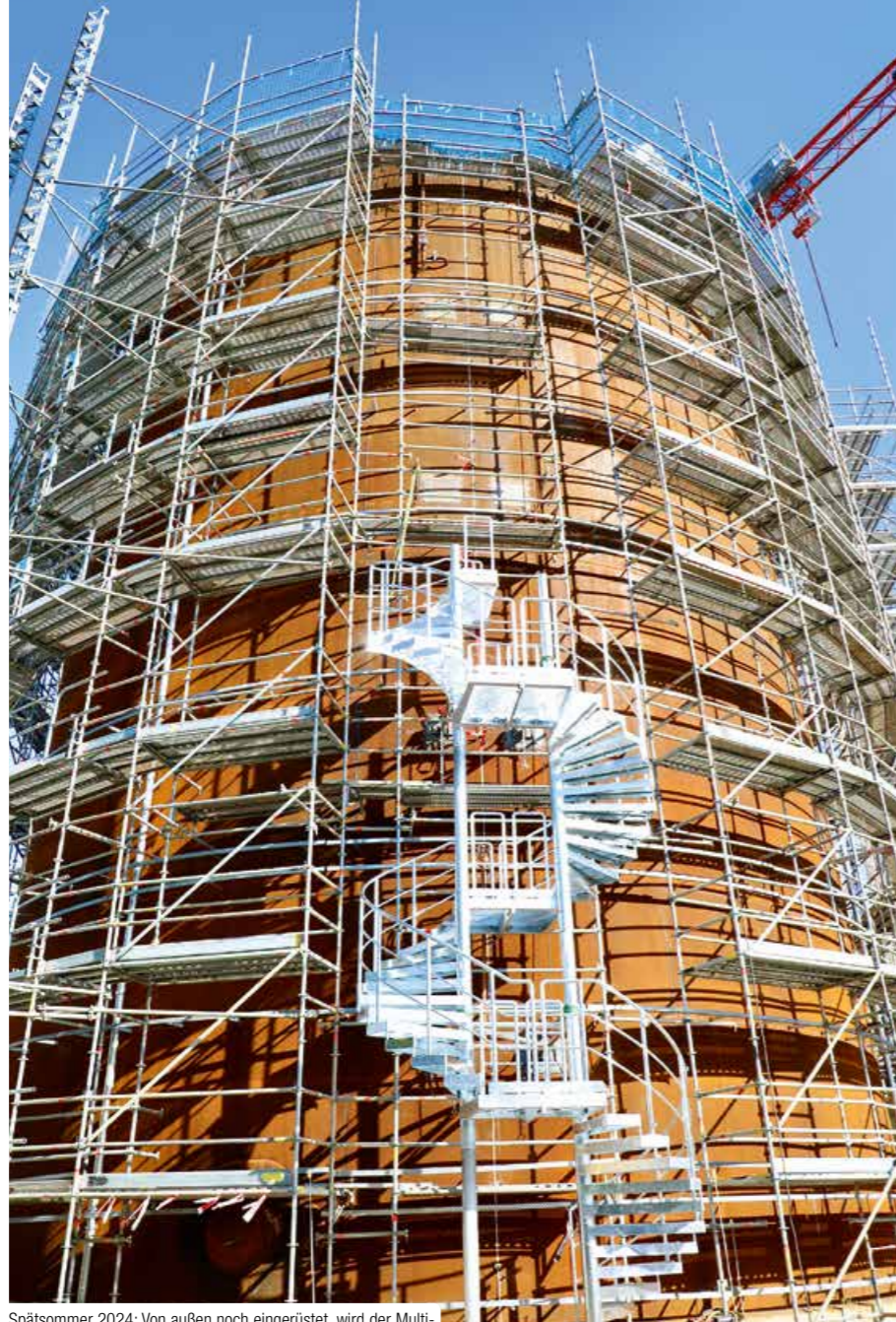
Spätsommer 2024: Von außen noch eingerüstet, wird der Multifunktionswärmespeicher innen bereits mit Wasser gefüllt.
