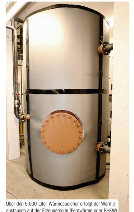
Über den 5.000-Liter-Wärmespeicher erfolgt der Wärmeaustausch auf der Erzeugerseite (Fernwärme oder BHKW) und der Abnehmerseite (Heizung, Trinkwasserbereitung oder Beckenwassererwärmung)
