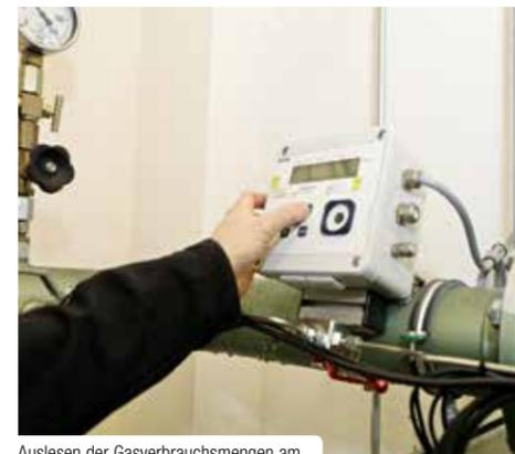
Auslesen der Gasverbrauchsmengen am Mengenumwerter des BioEG-BHKWs
