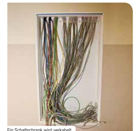
Ein Schaltschrank wird verkabelt
