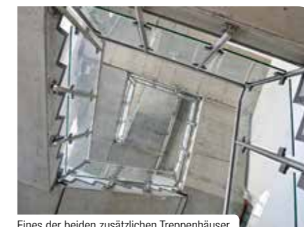
Eines der beiden zusätzlichen Treppenhäuser
